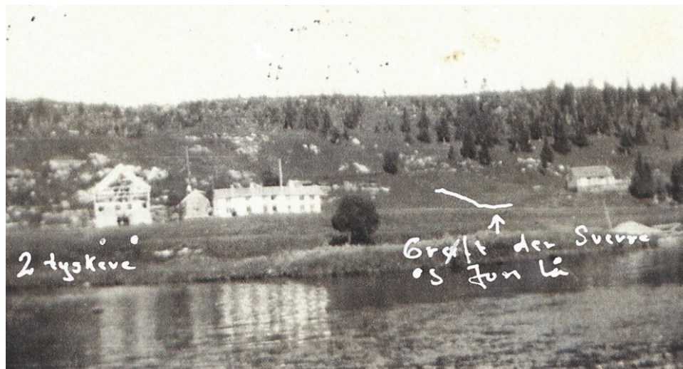
Holvassgården 1939. Bildet visr bygging av nytt fjøs.
