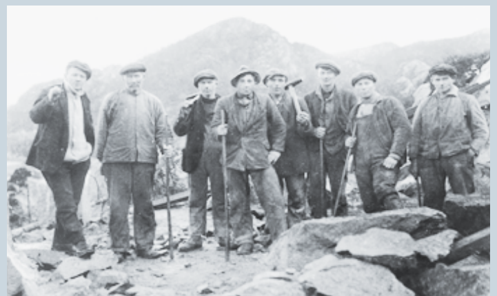
Veiarbeidere på Stjørnveien med datidens verktøy.
