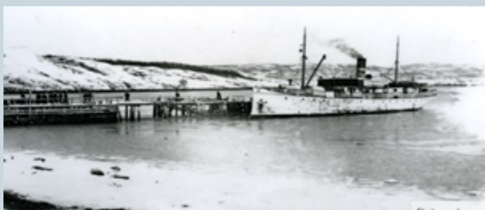
Rutebåten ved kaia på Refsnes.
