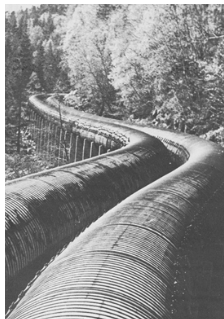
Rørgata fra dammene til kraftstasjonen. Bilde fra Jubileumboka.
