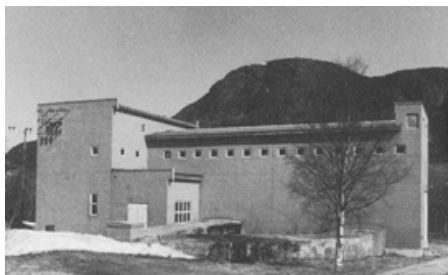
Kraftstasjonen i Teksdalen. Bilde fra Jubileumboka 1939-1989
