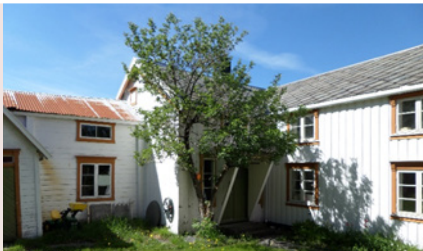
Boligen på Aspestranda. Ved å bygge i vinkel blir tunet skjermet mot den harde vestavinden. Her bodde J. A. Mollan ordfører i Stjørna 1905-1910 og 1917-1925.
