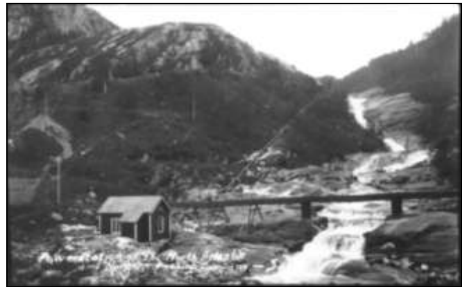
Kraftstasjon med gammelbrua (foto Johan Selnes)
