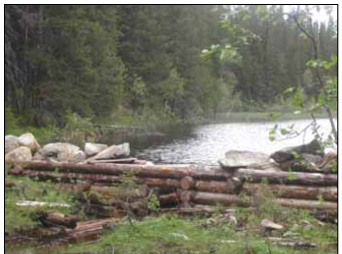
Tømmerkistedam. Mer vanlig var borddam med torv som tetting
