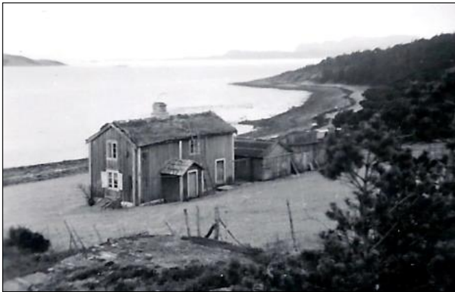
Edvindstua, hvor kula gikk gjennom veggen. Foto: Bj. S. 1953.
