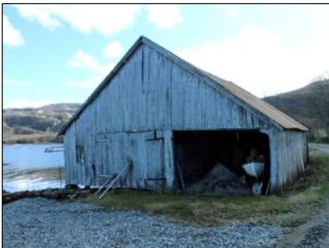
Der vi ser vinduet i naustet, er rommet hvor kassene ble spikret sammen. Foto: Magnar T. Selnes, 2014.
