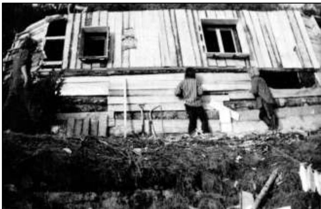
Reisverket er dekt med bord før torva legges på
