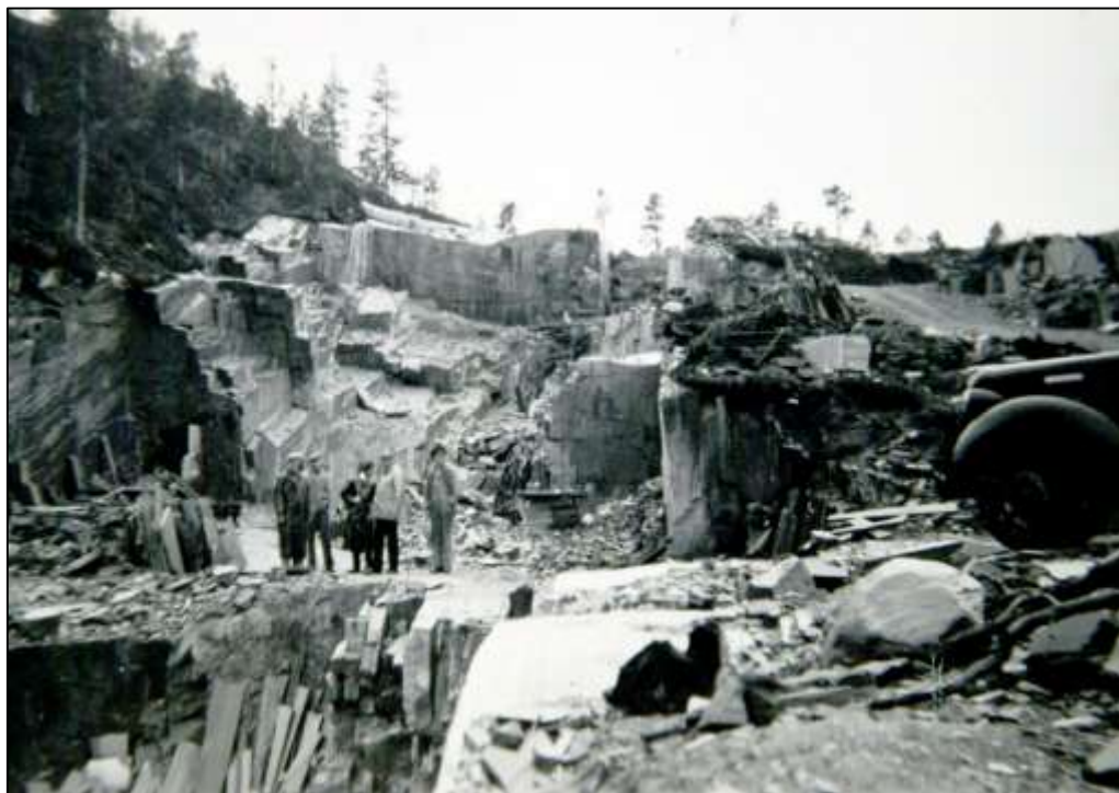
Store blokker tas ut etasjevis og deles til heller
