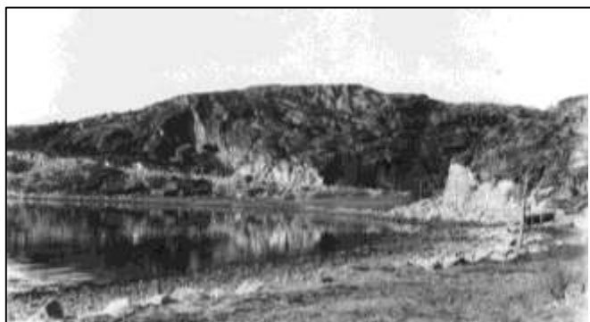
Veien under bygging i Saga - Stavika (Foto Johan Selnes)
