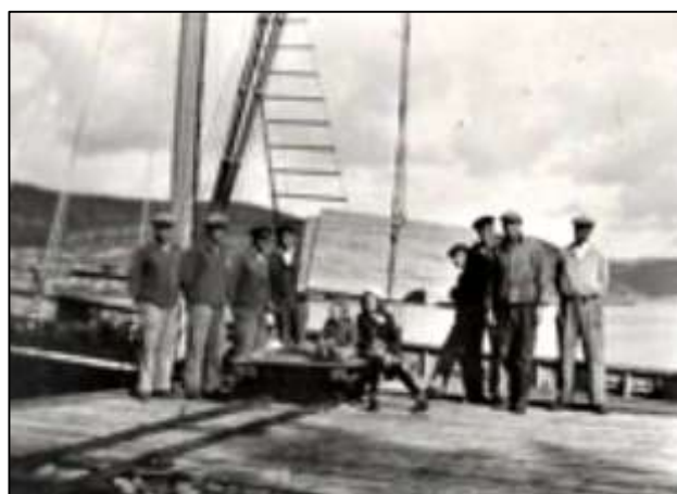
Lasting av heller på den gamle steinkaia
