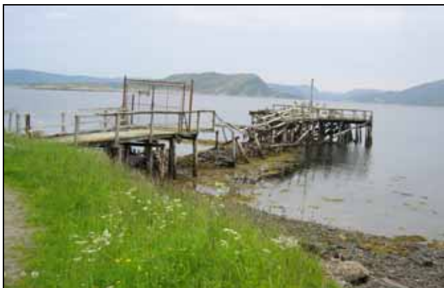
Kaia før restaureringen
